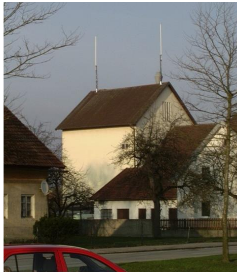
Abb. 1: Beispiel für eine Mobilfunksendeanlage mit omnidirektionalen Antennen.
