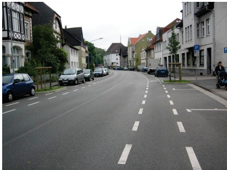
Bild 7 Schutzstreifen mit Sicherheitstrennstreifen zu parkenden Kfz (Lemgo)
