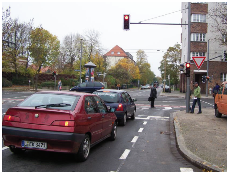
Bild 12 Vorbeifahrstreifen in einer signalisierten Knotenpunktzufahrt (Leipzig, Foto Gloßat)
