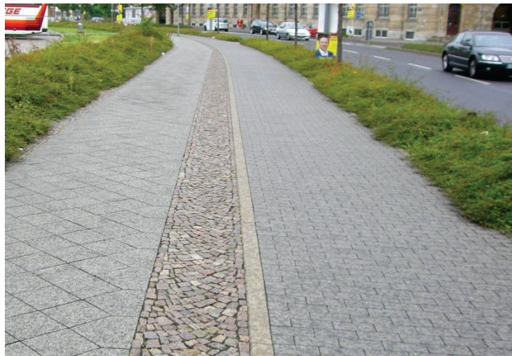
Bild 1 Vom Gehweg baulich getrennter Radweg (Leipzig)
