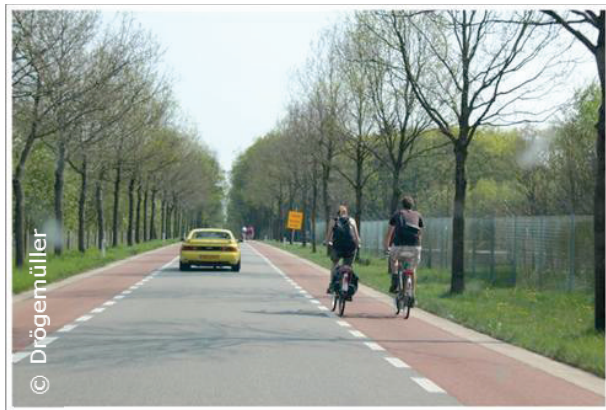
Bild 15 Teststrecke für Schutzstreifen außerorts (Deutschland)
