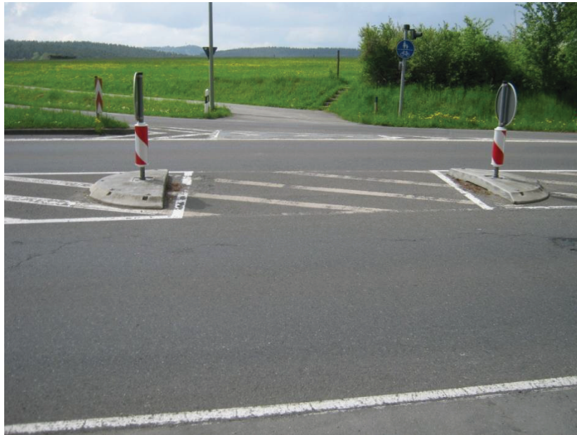
Bild 44: Mittelinsel Thiergärtner Straße und zu gering dimensionierte Aufstellfläche am ungesicherten freien Rechtsabbieger
