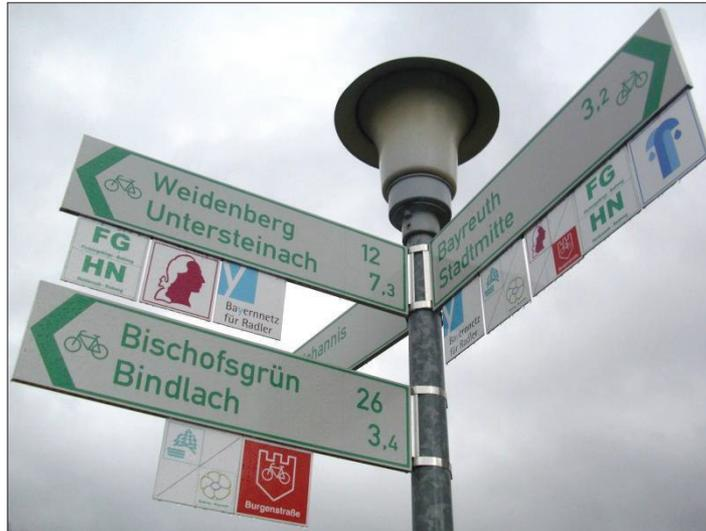
Bild 210: Mangelhaft montierte Pfeilwegweiser in Bayreuth
