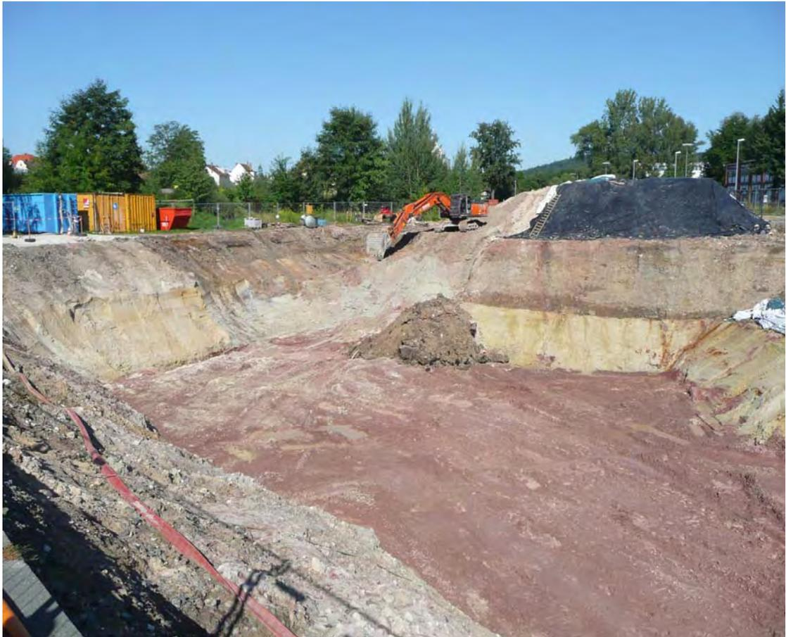
Das über 1.000 m<sup>2</sup> große Grundstück wurde teilweise bis 8 m tief ausgebaggert. Insgesamt wurden im Rahmen der Sanierungsmaßnahme **ca. 22.500 Tonnen (11.250 m<sup>3</sup>) Boden ausgehoben und entsorgt**. Darüber hinaus fielen ca. 420 Tonnen (210 m<sup>3</sup>) Bauschutt zur Entsorgung an.
