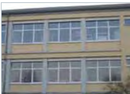
Gewerbliche Berufsschule Bayreuth, sanierte Westfassade des Nordflügels
