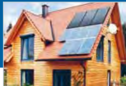
Solarthermie und Photovoltaik auf einem Dach (Quelle: BSW-Solar)
