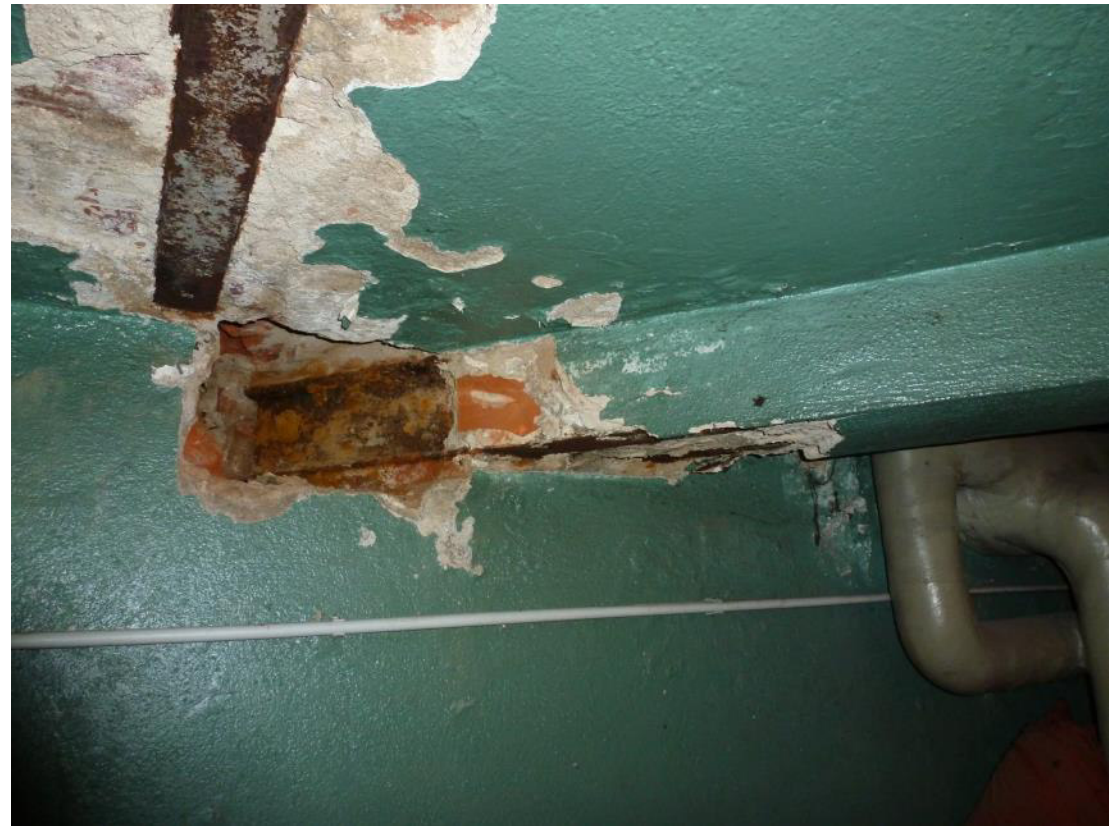
Substanzschäden im Bereich der Kellerflure und Schächte
