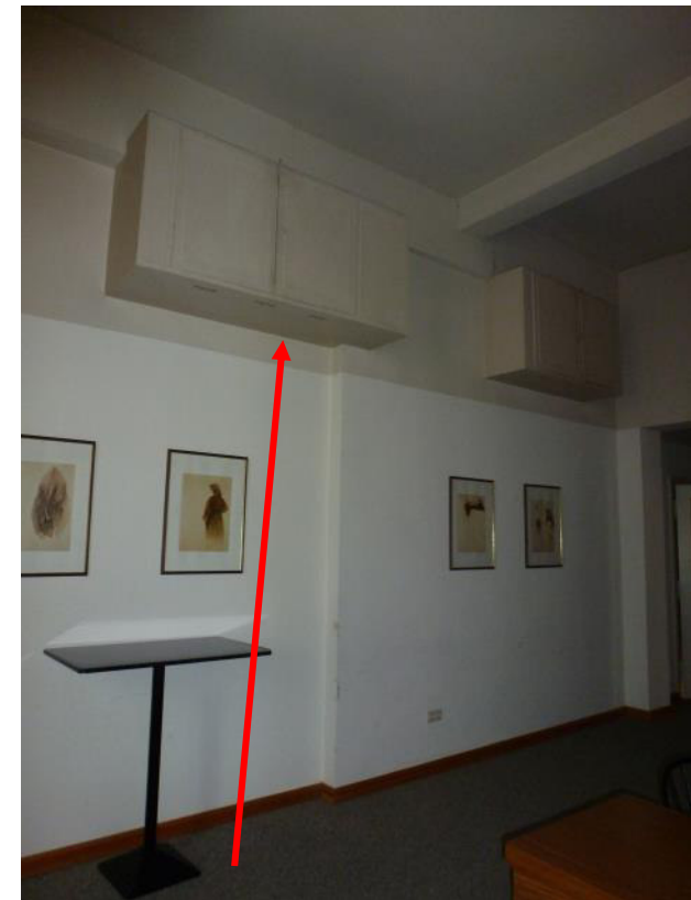
„Beleuchterplatz“ Kl. Haus – bedienbar nur durch Anstellen einer Leiter!
