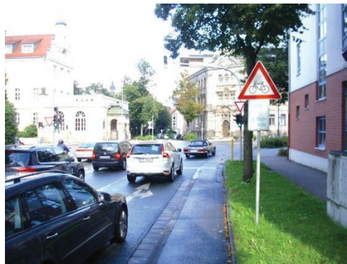
Bild 93: Bismarckstraße, Richtung Osten, schmaler Bordsteinradweg und Warnzeichen für Kraftfahrer
