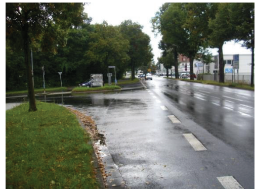
Bild 72: Einmündung Eremitagestr. von Osten: übermäßige Aufweitung der Einmündung (vgl. Bild 71)
