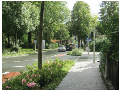
Bild 61: Nibelungenstr.: Einfahrt von Norden über kurzen Radfahrstreifen
