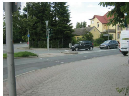
Bild 84: Stark verschwenkte Radverkehrsführung an der Einmündung Friedrichstraße
