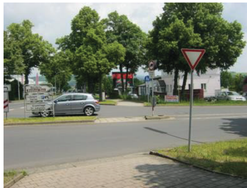
Bild 71: Einmündg. Eremitagestr.: Geh-/Radweg deutlich abgesetzt, ungesicherte, nicht bevorrechtigte Querung
