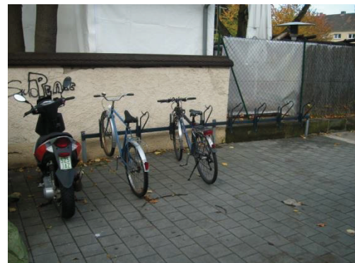
Bild 160: Veraltete, teils verbogene Vorderradhalter
