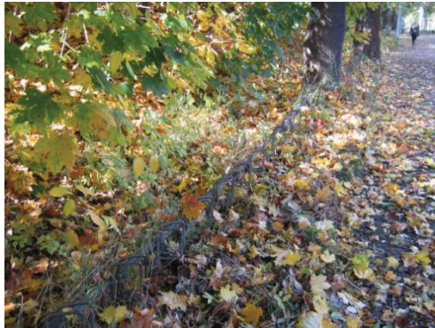
Bild 173: Zugewachsene und z. T. verbogene Vorderradhalter gegenüber der Oberfrankenhalle
