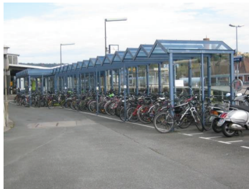
Bild 151: Überfüllte Abstellanlage am Hauptbahnhof Bayreuth
