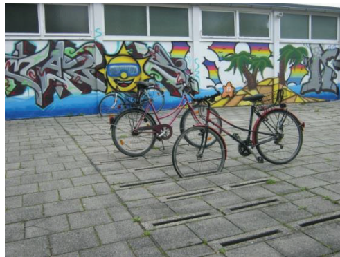
Bild 187: Fahrradparkplatz mit eingelassenen Betonfahrradständern
