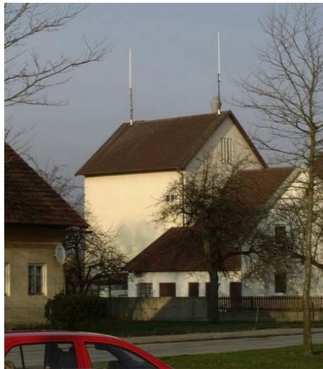
**Abb. 1:** Beispiel für eine Mobilfunksendeanlage mit omnidirektionalen Antennen.
