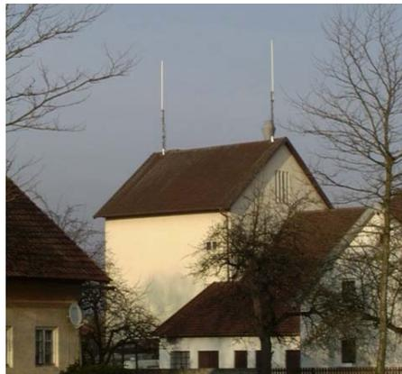
**Abb. 1:** Beispiel für eine Mobilfunksendeanlage mit omnidirektionalen Antennen.
