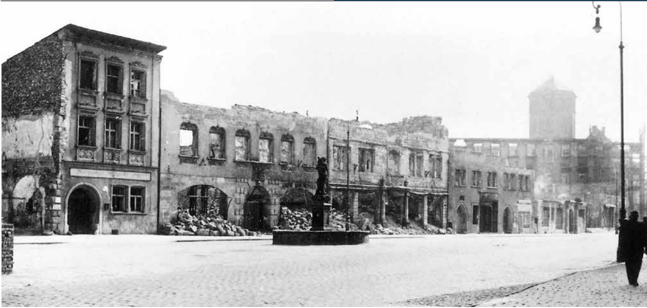
Die ausgebrannte Nordseite des Marktplatzes
