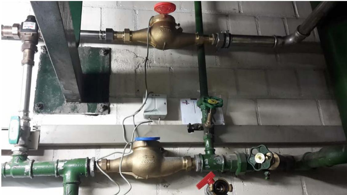
2019 wurden neue Wasserzähler zum Erfassen des Verbrauchs, der bei der Kälteerzeugung auftritt, eingebaut.
