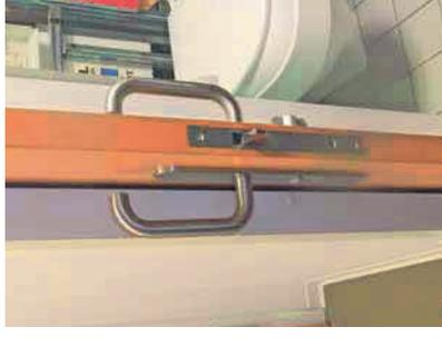
Greifgünstige Griffe, wie z. B. bogenförmige Griffe oder Bügel. Auf ausreichend lichte Durchgangsbreite achten, der Griff muss bei der Planung der Rohbauöffnung berücksichtigt werden.
