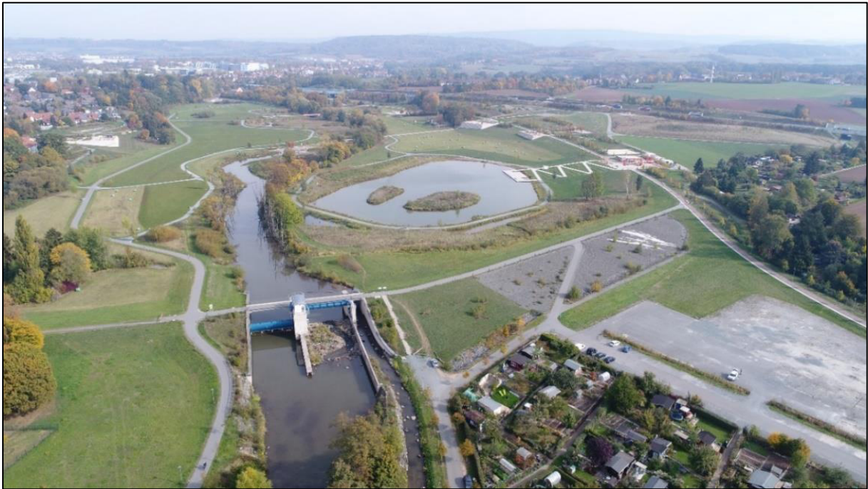
Abbildung 15: Hochwasserrückhaltebecken Einschöpfung Bayreuth auf dem Landesgartenschau Gelände
