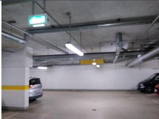
In der Tiefgarage muss ein Teil der Beleuchtung immer in Betrieb sein. Diese besteht noch aus herkömmlichen T-8 Lampen. Auch bei Leuchtstoffröhrentausch werden immer noch T-8 Röhren verwendet.
