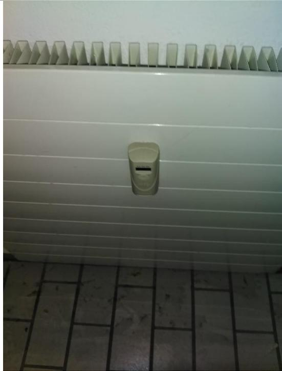
An den Heizkörper sind teilweise „Verdunster“ angebracht, die zum Ablesen der Wärmemenge dienen. Diese scheinen aber nicht mehr genutzt zu werden.
