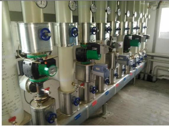
In der Heizkreisverteilung sind bereits drehzahlregelte Pumpen der ersten Generation installiert.
