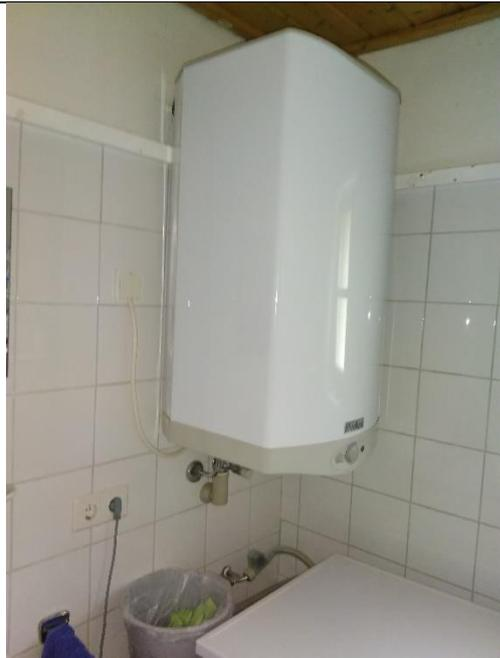
Die Warmwasserbereitung im „Altbau“ erfolgt dezentral, elektrisch.
