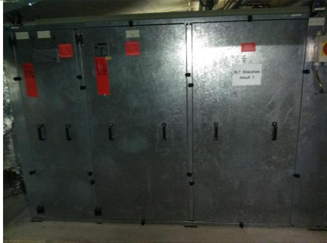
Im Dachgeschoss wurden zwei Lüftungsanlagen installiert. Diese erfüllen die „Aufgabe“ heizen, lüften, kühlen. Baujahr 1995, 25.000 m<sup>3</sup>/h Volumenstrom.
