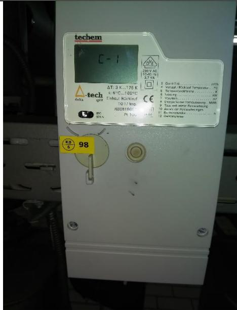
Der Hauptwärmemengenzähler ist defekt bzw. nicht am Volumenzählwerk angeschlossen. Der Hausmeister notiert monatlich den „Durchfluss“. Mit diesem kann aber keine genaue Aussage zum Wärmeverbrauch getroffen werden.
