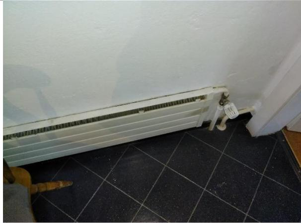
Die Wärmeabgabe im „Altbau“ erfolgt über Heizkörper. Die Leistung der Heizkörper erscheint zu gering.
