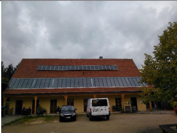
Auf dem Dach des Unterkunftsgebäudes, ist sowohl eine Photovoltaikanlage, als auch eine thermische Solaranlage installiert.
