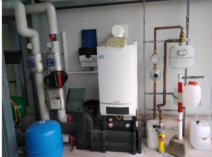
Die Beheizung der „LKW Garage“ erfolgt über ein Gasbrennwertgerät. Buderus Logamax GB162, Leistung 85 kW, Baujahr 2015.
