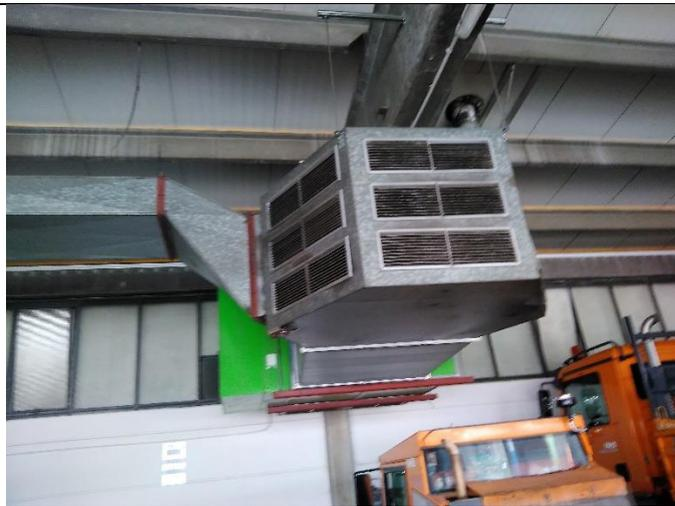
Eine der älteren Hallen, wird über eine direkt-befeuerte-heizöl Lüftungsanlage frostfrei gehalten. Die genaue Typenbezeichnung konnte nicht gefunden werden.
