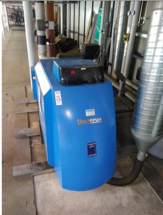
Die Werkstatt wird über einen Ölbrennwertgerät beheizt. Buderus Logano plus GB 225, Baujahr 2015, Leistung 70 kW.
