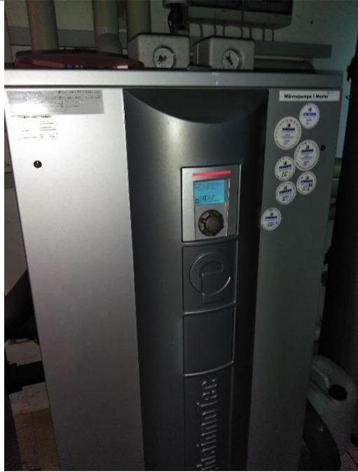
Die anderen Gebäudeteile werden über zwei Solewärmepumpen beheizt. Alpha Inotec SWC 170 H, Baujahr 2005, Leistung jeweils 16,5 kW.
