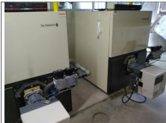
Die beiden Wärmeezeuger befinden sich im Dachgeschoß. Zwei Gaskessel De Dietrich GT 409, Baujahr 1995, mit jeweils 350 kW Leistung.
