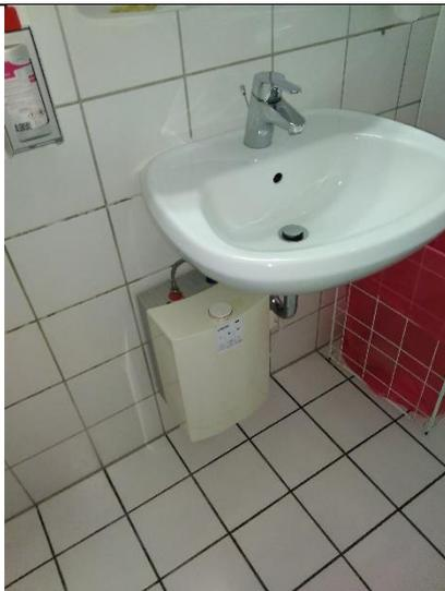
Die Warmwasserversorgung erfolgt dezentral, elektrisch, mit Boilern und Durchlauferhitzer.
