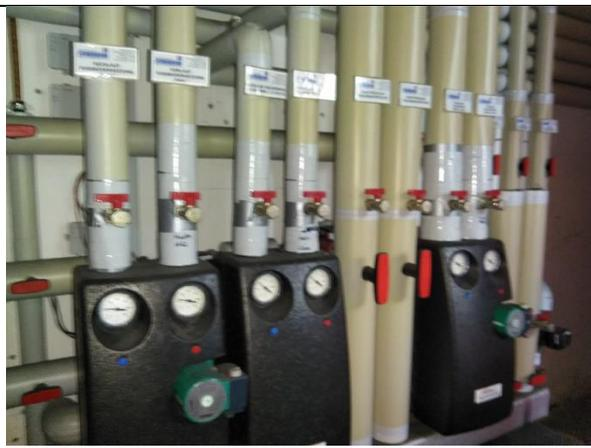
In den Heizkreisen sind noch Konstantpumpen verbaut.
