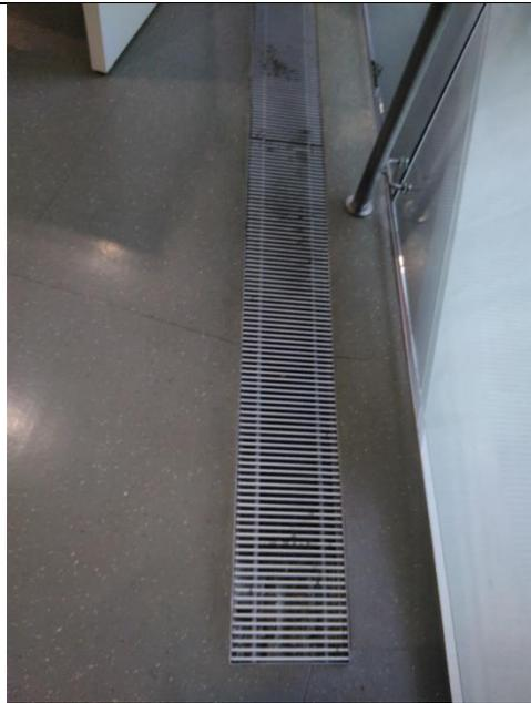
Die Bücherei wird über Bodenkonvektoren und der Lüftungsanlage beheizt. Aber auch beide Systeme haben zu wenig Heizleistung.
