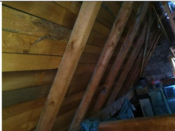
Das Dach, des „Altbaus“ ist zum größten Teil ungedämmt.
