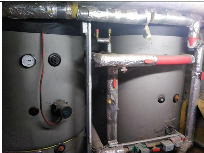
Es wurden zwei Pufferspeicher, mit jeweils 825 Liter installiert. Für den „Notfall“ wurde in einen Pufferspeicher, ein Elektroheizstab installiert.
