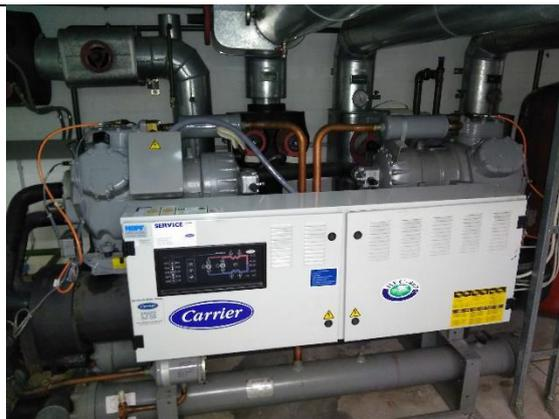
Zur Kühlung der „Halle“ wurde eine Kältemaschine installiert. Mittels der Lüftungsanlage erfolgt dann die Kühlung.
