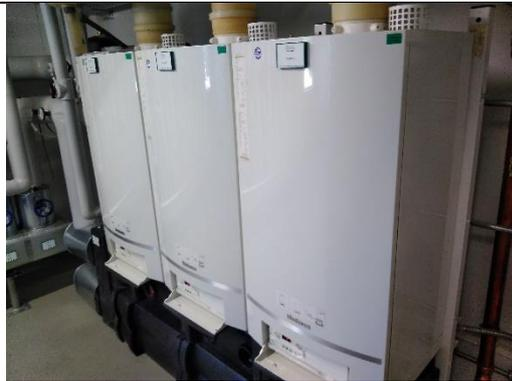
Die Spitzenlastwärmeabdeckung erfolgt über drei Gasbrennwertgeräte. Buderus GB 167, Baujahr 2016, Leistung jeweils 85 kW.
