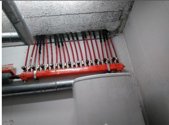
Die Fußbodenheizung für den „Sitzungssaal“ läuft ständig, unregelt durch.
