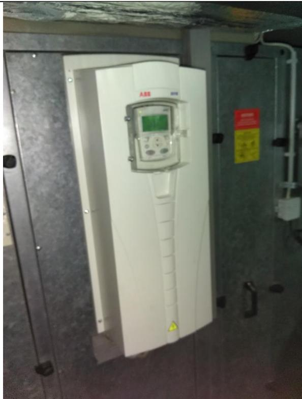
Die Motoren der Lüftungsanlagen sind bereits frequenzgesteuert.
