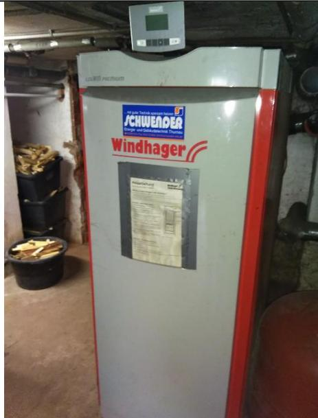
Der „Altbau“ wird ausschließlich mit einer Stückholzheizung beheizt.
