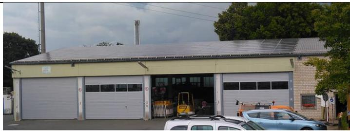
Auf dem Lagergebäude ist eine Photovoltaikanlage mit rund 70 kWp, zum Eigenverbrauch installiert.
