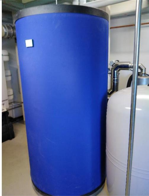
Für den gleitenden Betrieb des Blockheizkraftwerkes, wurden ein Pufferspeicher mit 1.000 Liter Volumen installiert.
