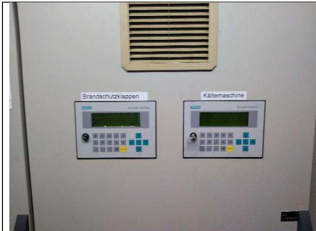
Die Regelung der Kühl- und Lüftungsanlage erfolgt über eine Siemens Gebäudeleittechnik.
