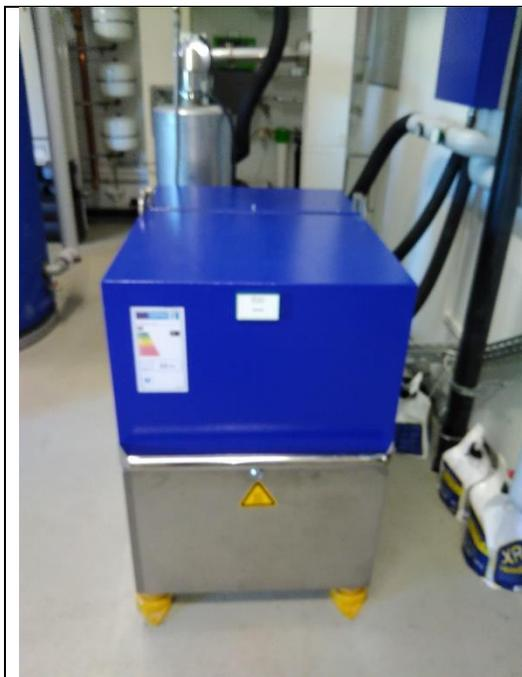
Zur Grundwärmeversorgung der Turnhalle, wurde ein Blockheizkraftwerk installiert. EC POWER XRGI 6, Heizleistung 19,4 kW, elektrische Leistung 6 kW, Baujahr 2015. 28.765 Betriebsstunden
