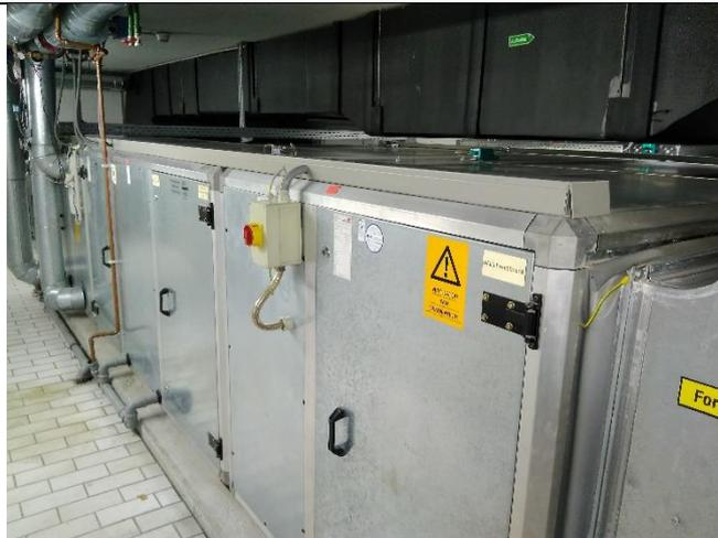
Die Lüftungsanlage „Halle“ verfügt über eine Wärmerückgewinnung. Die Kühlleistung beträgt 135 kW, der Volumenstrom beträgt 300 m<sup>3</sup>/h.
