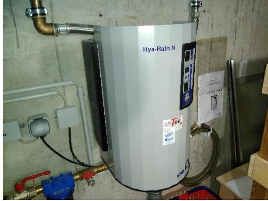
Das Gebäude verfügt über eine Zisterne, an der hauptsächlich, die Toilettenspülungen angeschlossen sind. Leider scheint das System nicht richtig zu funktionieren.
