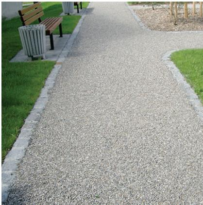
*Asphaltdecke mit Splittoberfläche*
