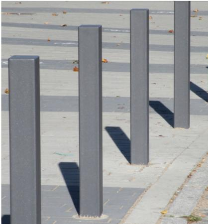
Beispiele Poller aus Rechteckrohr und aus Flachstahl
