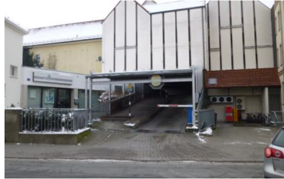
Abbildung 64: Einfahrt Parkgarage (Dilchertstraße 11)
