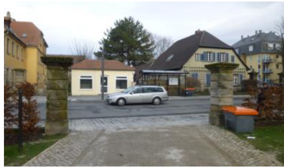
Abbildung 69: Blickrichtung auf Richard-Wagner-Straße 45
