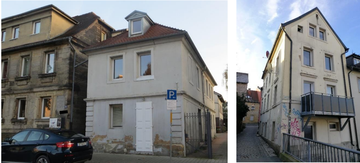
Abbildung 25: Schlechte Gebäudezustände (mittlere Badstraße / Rosenau)
