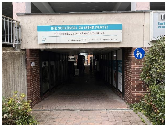
Abbildung 72: Innenhof Passage Badstraße – Richard-Wagner-Straße
