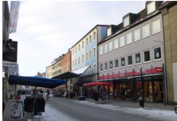
Abbildung 13: „Mix“ aus verschiedenen Baualtersklassen entlang der R.-W.-Straße (Nr. 11-15)
