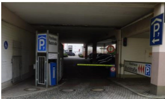
Abbildung 33: Zufahrt zum Parkhaus Badstraße
