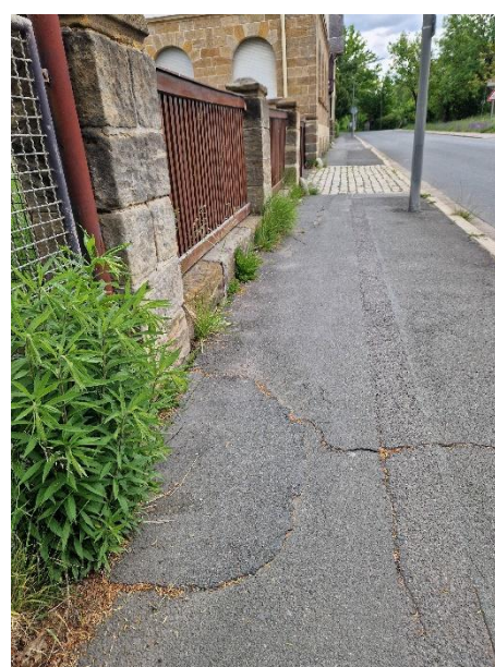
Bild 97: Gravenreutherstraße (12) – Gehweg Höhe Gravenreutherstraße Nr. 3
