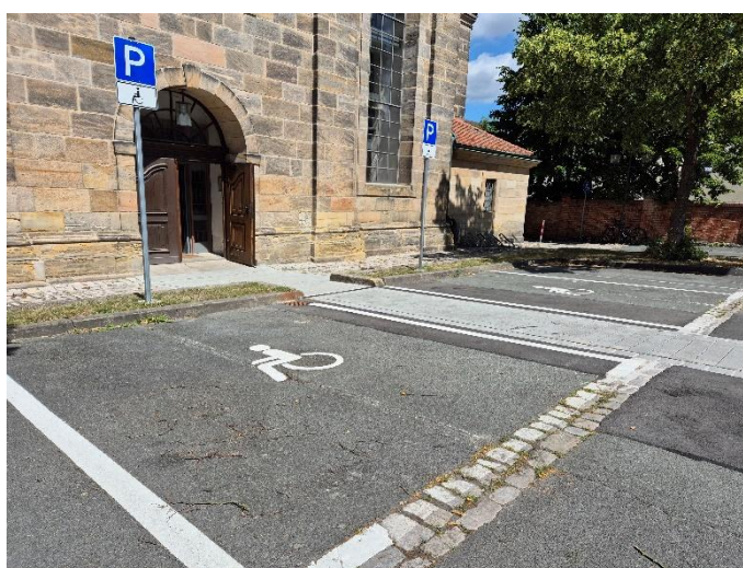
Bild 10: Hinterer Kircheneingang nach Umbau
