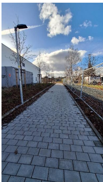
Bild 34: Ludwig-Thoma-Straße - neuer Weg zwischen Radweg und Einkaufszentrum
