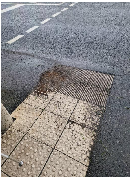
Bild 115: Wolfsbach (12) – taktile Aufmerksamkeitsfelder im Bereich der Ampelanlage
