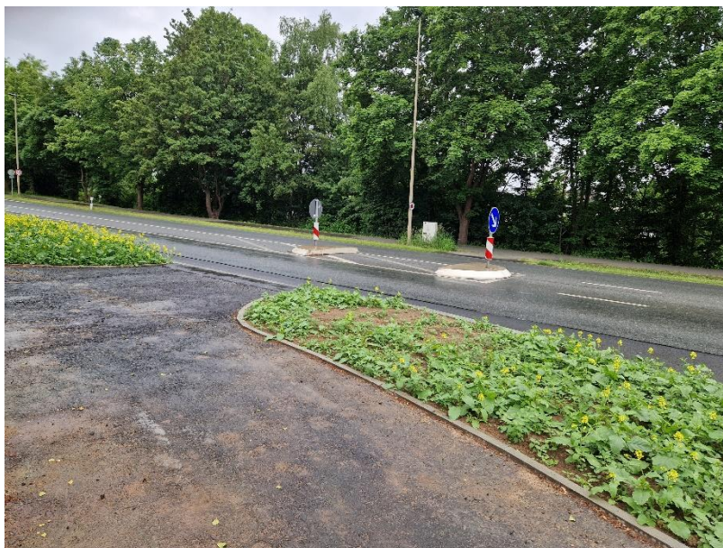
Bild 105: Wolfsbach (2) – Querungshilfe Bundesstraße 2
